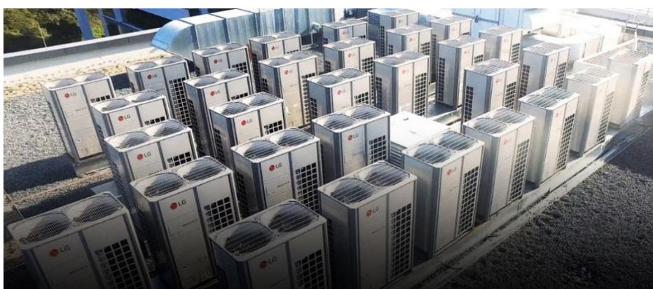
Hình 1. Lắp đặt cụm dàn nóng máy lạnh loại VRF trên sân thượng
