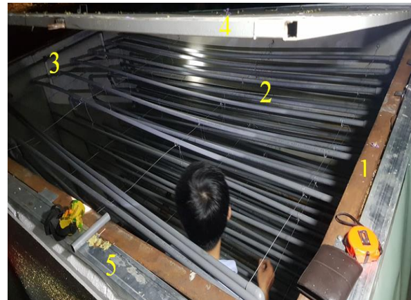
1-Vách bồn; 2-Dàn ống trao đổi nhiệt; 3-Ống góp; Nắp bồn; 5-Vách cách nhiệt.
