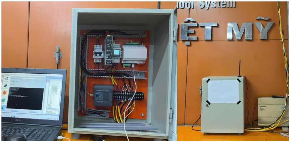
Hình 4 Hiện trường lắp đặt tủ điện và cảm biến nhiệt độ - độ ẩm
