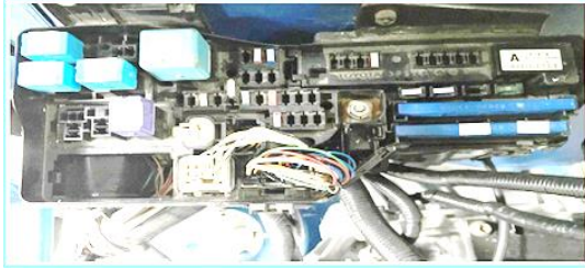
Hình 5. Mạch nguồn sau khi thi công.
